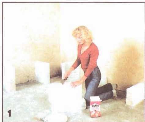
1 Основание углового диванчика делают из газобетонных блоков.
