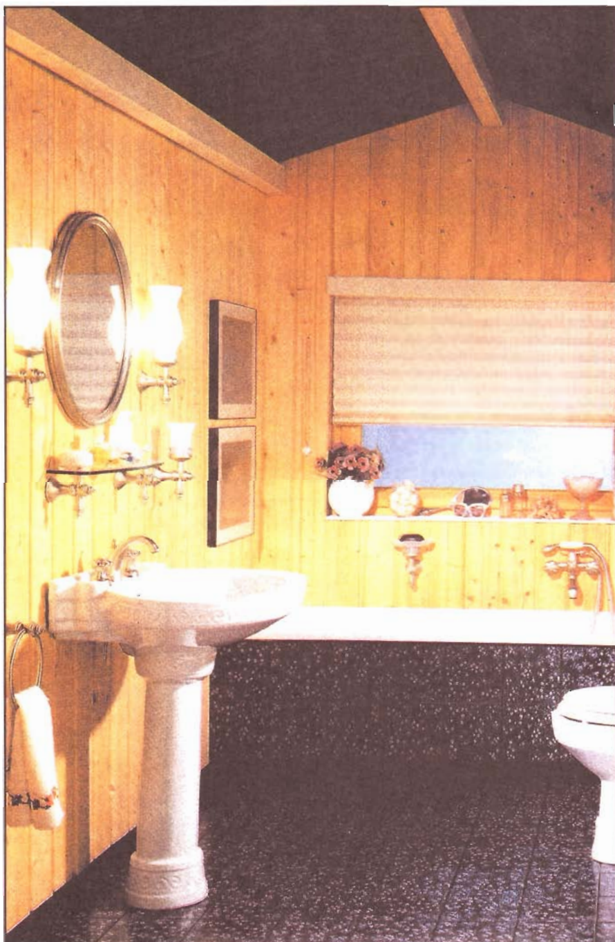
Обшивка потолка по цвету сочетается с тоном керамической плитки. Шпунтованные доски в «сырой зоне» стены (за ванной) покрыты бесцветной защитной лазурью.
