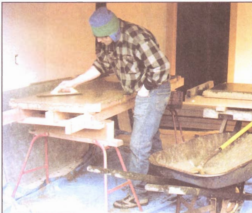
Стык секций обрабатывают шлифовальной машинкой, после чего все оставшиеся микрорупустоты затирают пастой из акриловых добавок и портландцемента.
