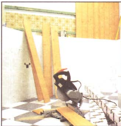
Раскрой досок по длине удобно производить маятниковой пилой.
