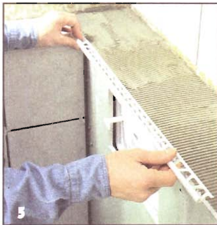
На переднюю кромку цоколя накладывают декоративный ажурный уголок из пластмассы.
