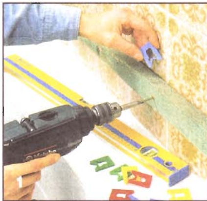
Дерево и плитка идеально сочетаются в интерьере. Обрешетка из брусков служит основой для крепления вагонки.
