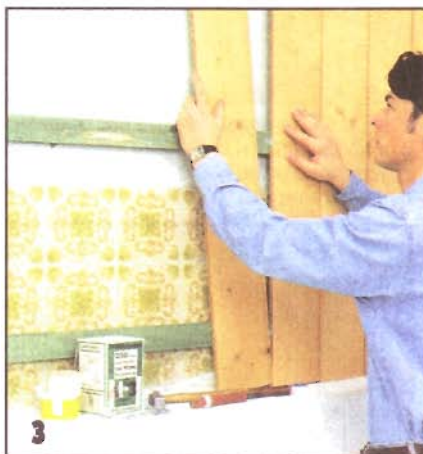
За внутреннюю стенку паза доски обшивки крепят к брускам обрешетки с помощью кляммеров.
