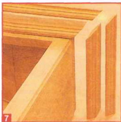
7 В углах профилированные детали карниза запиливают «на ус».
