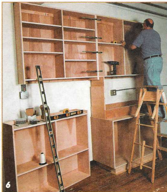
Установка шкафчиков. Во время крепления шурупами навесного шкафчика к стене, чтобы недержат его на весу руками, под него подставляют опоры.
