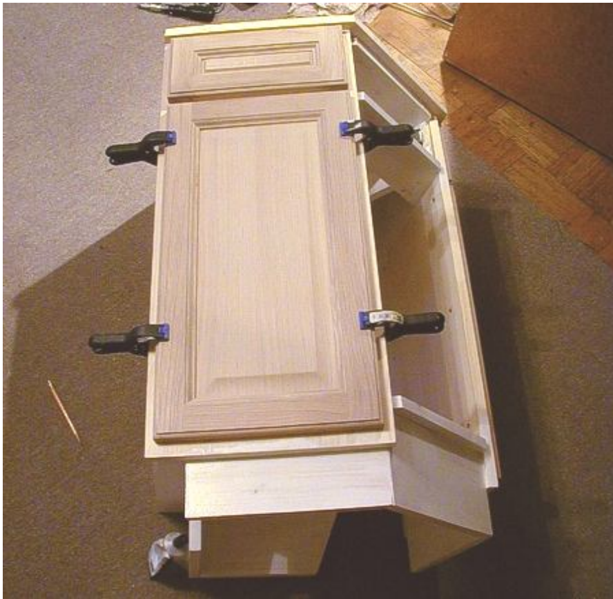
Нижняя часть с приклеенными дверцами
