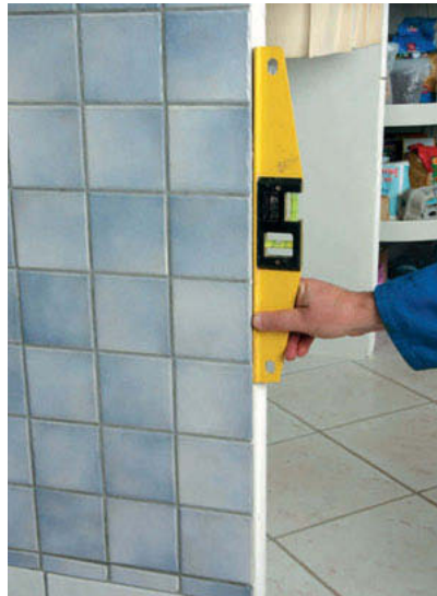
Vérifiez l'aplomb des surfaces verticales.
