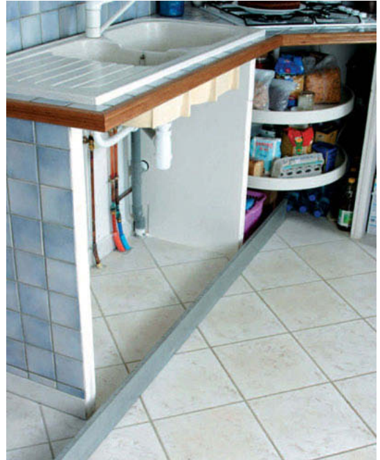
Cette grande règle permet de contrôler la planéité du sol.
