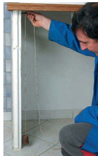
Vérification avec un fil à plomb.
