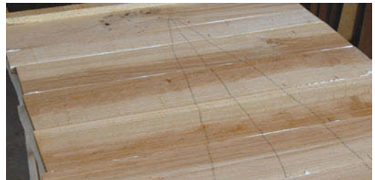
Panneau présentant des traces de colle.
